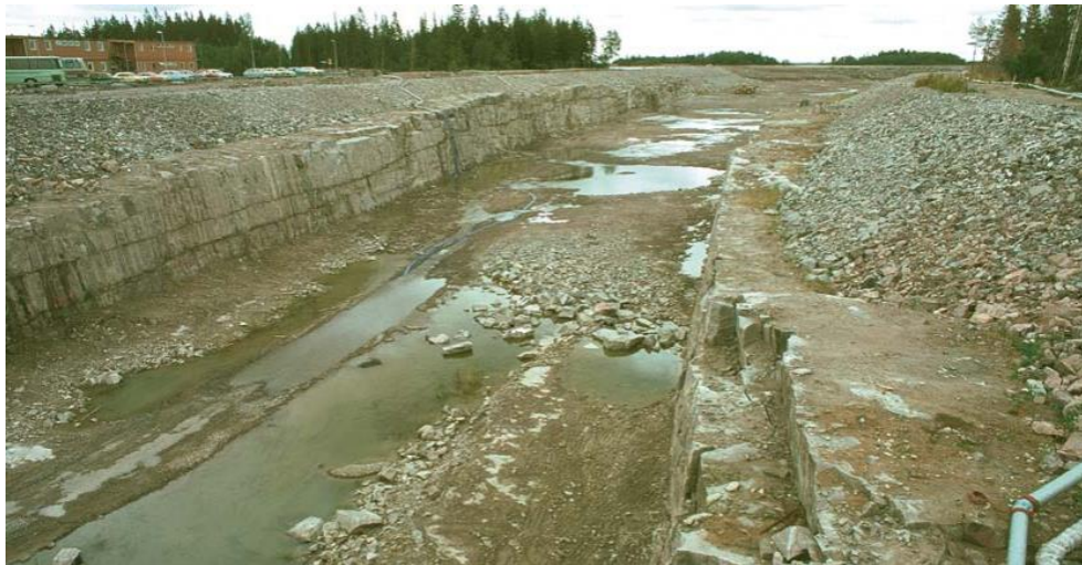
Figur 2-2. Foto taget från anläggandet av Forsmarks kärnkraftverks kylvattenkanal. Till vänster i bilden syns exempel på yttära, horisontella och vattenförande sprickor.
