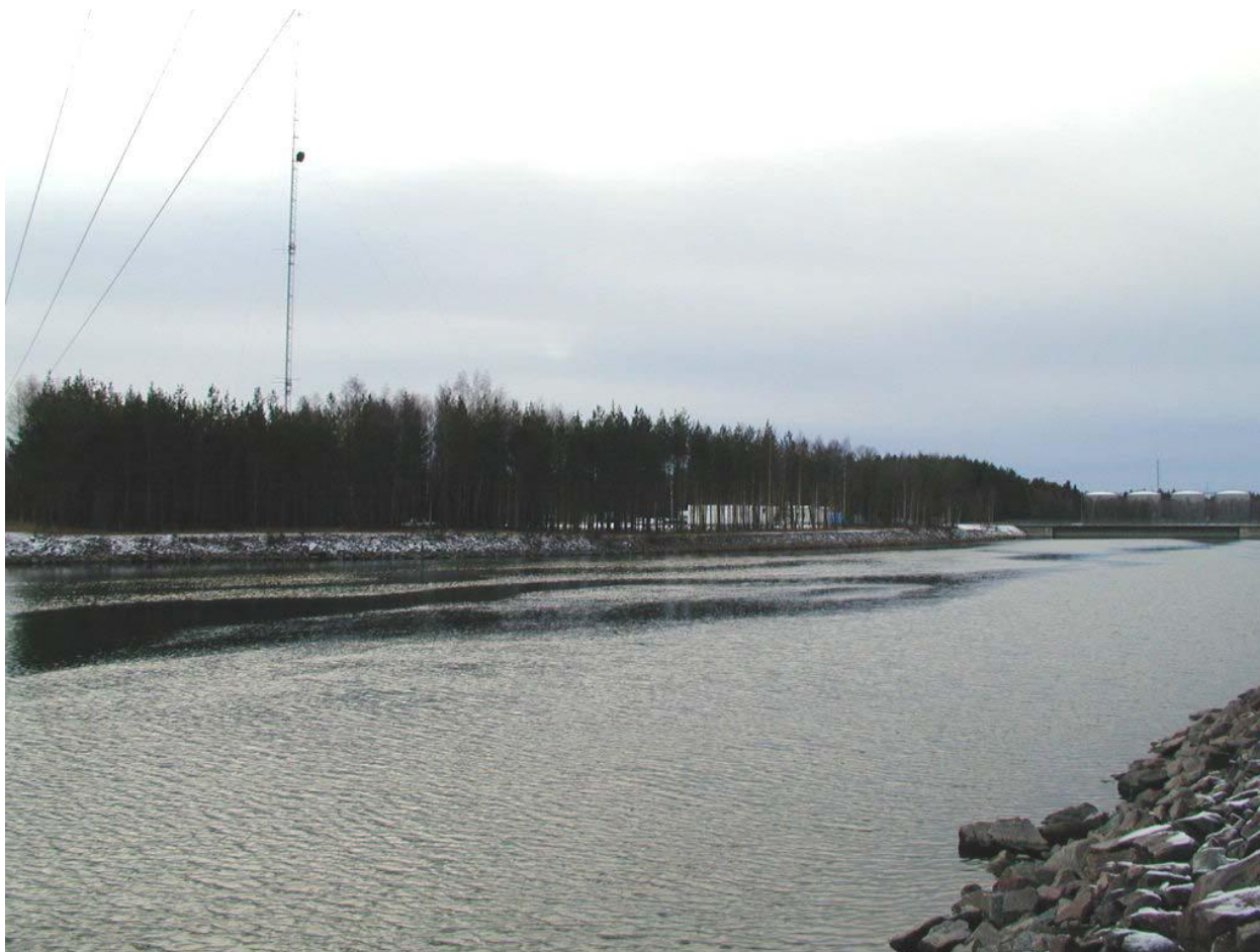
Figur 4-2. Fotografi taget från norr mot sydväst vid läget för den planerade nya bron över kylvattenkanalen /Krona och Krona 2009/.
