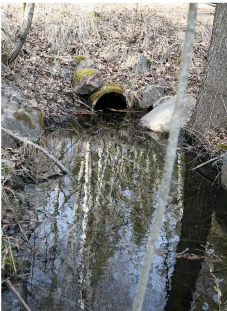
Figur 5-2. Fotografi av Tjärnpussens nuvarande utlopp i sjöns norra del (se översiktskartan i Figur 1-1). Utloppet består av en betongtrumma (som utgör sjötröskel) under en gång- och cykelväg.
