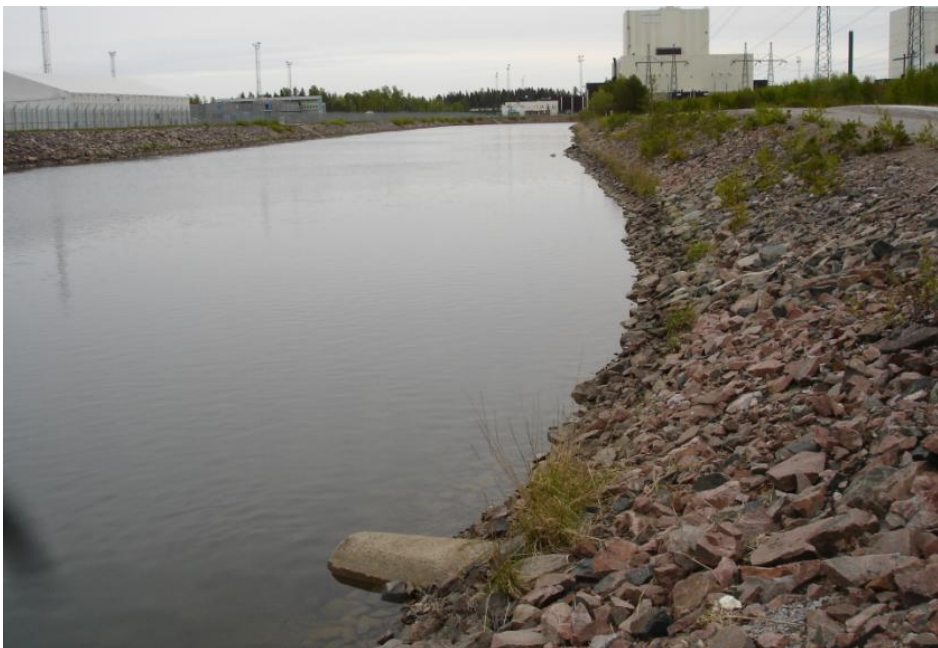
Figur 5-4. Fotografi av dikets mynning (betongtrumman i bilden) vid FKA:s kylvattenkanal.
