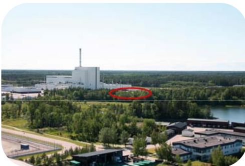
Inkapslingsanläggning i Forsmark
