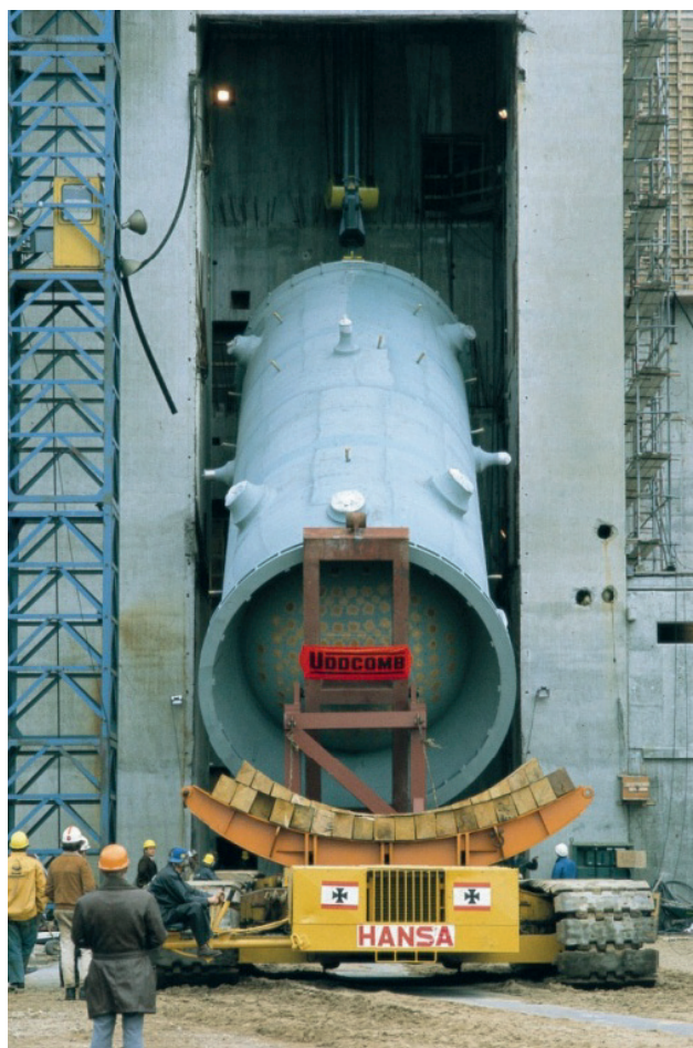
Figur 4-2. BWR-reaktortank vid installationen i Barsebäcks kärnkraftverk.
