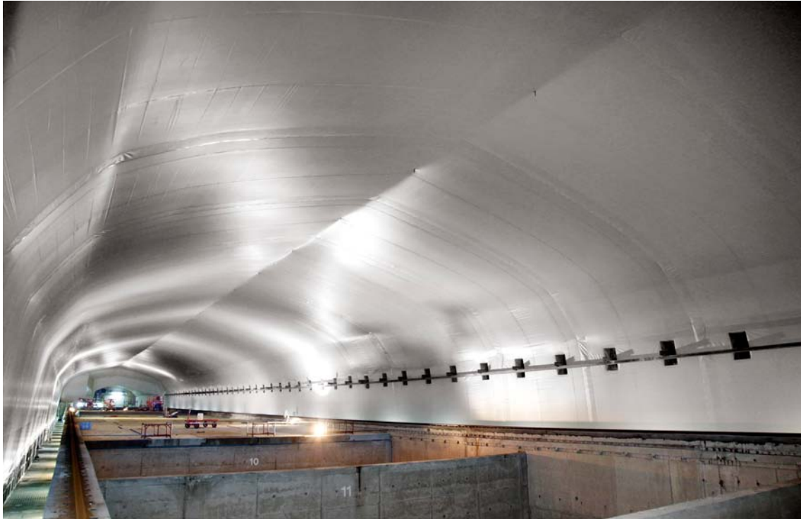
Figur 4-3. Nyligen installerad tunnelduk i befintlig BMA.
