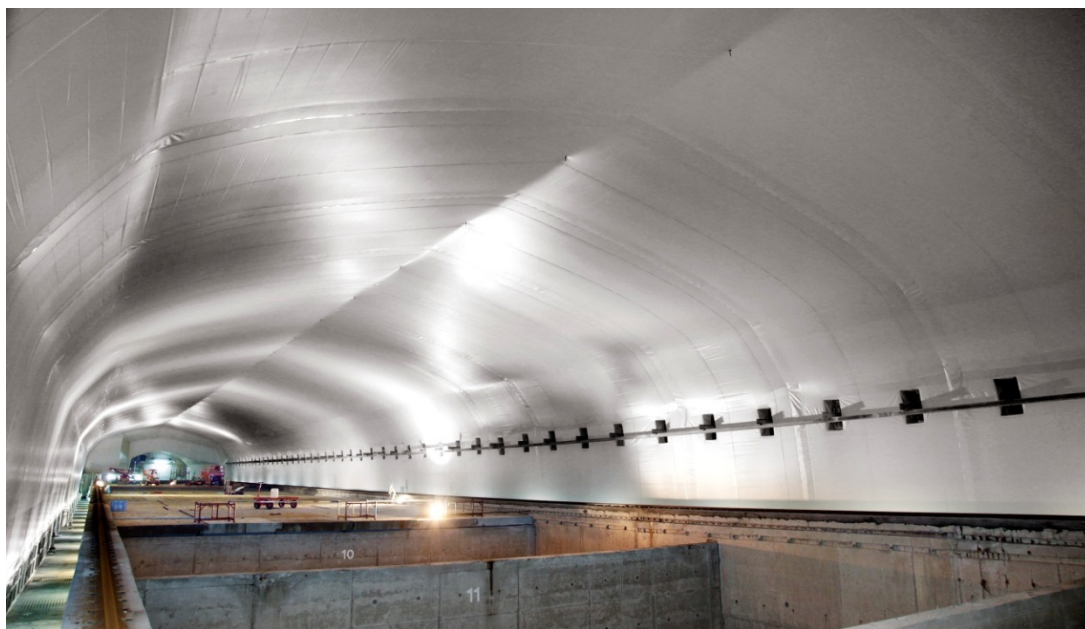
Figur 4-7 Foto visande 1BMA, befintlig bergsal för medelaktivt avfall.
