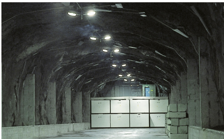
Figur 4-11. Vy över bergsal 2BTF. Prefabricerade betonglock syns ovanpå betongtankarna.
