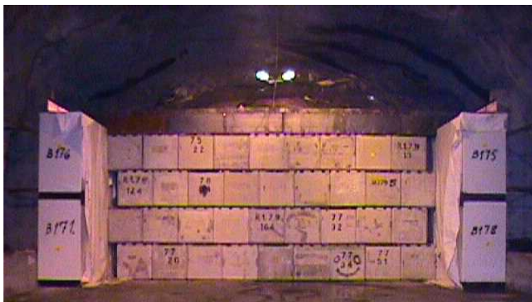
Figur 4-9. Vy visande 1BTF med stödmuren av betongkokiller i mitten och betongtankarna längs sidorna av bergsalen. Duken på betongtankarnas insida förhindrar att cementen rinner ut vid kringgjutningen av faten.
