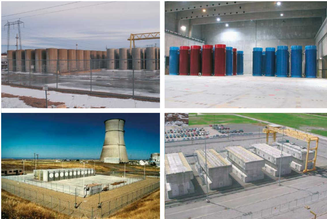
Figur 3-8. Exempel på anläggningar för torr lagring. Överst till vänster: Utomhuslagring vid Point Lepreau Generating Station i Kanada, källa: NBPower Nuclear. Överst till höger CASTOR®-behållare i lagerbyggnad vid Gorleben i Tyskland, från Vossnacke et al. (2003, källa: IAEA). Nederst till vänster NUHOMS® vid Susquahanna kärnkraftverk i USA, från Roland et al. (2003, källa: IAEA). Nederst till höger CANSTOR®-moduler vid Gentilly-2 i Kanada från NWMO (2004, källa: Hydro Quebec).
