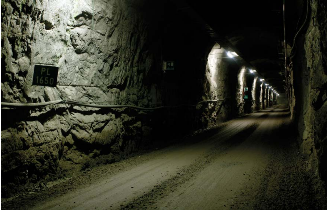
Figur 4-2. Tunnelbygge i Olkiluoto i Finland.
