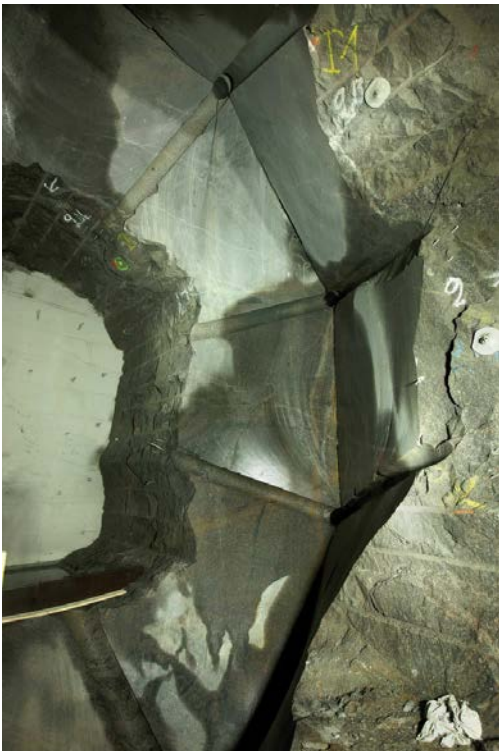
Figur 13-12. Vadersågad slits för betongkupolen i fullskaleexperimentet. Höger sida av TAS01 (se figur 13-8). Bergtagget genomfördes 2012.
