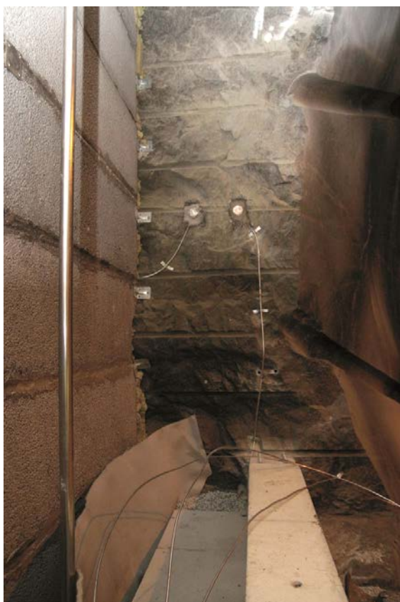
Figur 13-9. Detaljfoto från installationen av fullskaligt test av det kompletta pluggsystemet. Bilden visar (från vänster) filter av lecabalkar och makadam, dräneringsrör (avluftning), geotextil, bentonittätning med MX-80-lera (block och pelletar) samt betongbalkar. Alla givarkablar leds i stålrör på experimentets trycksida.
