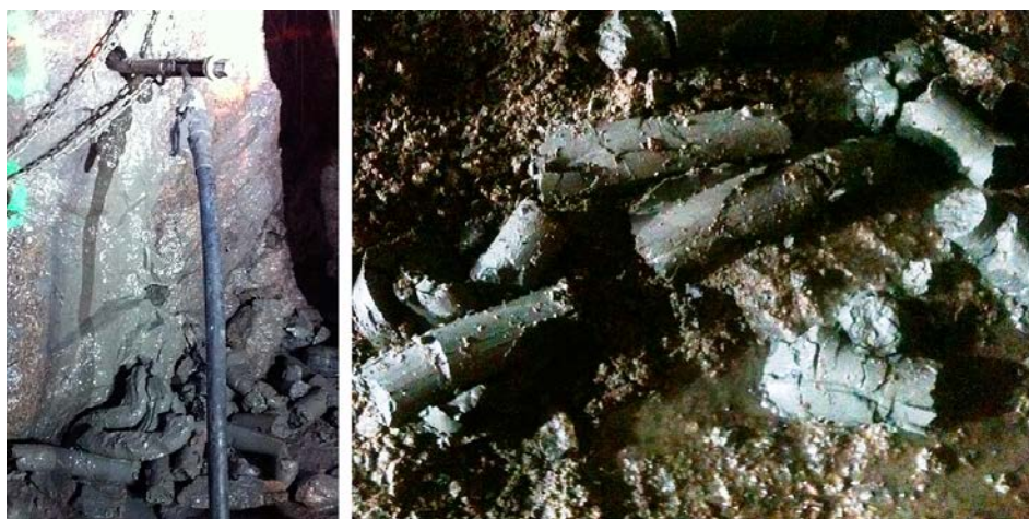
Figur 4-20. Uttryckt bruk i samband med kompletterande injektering.
