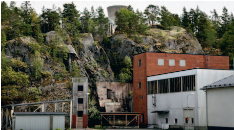
Utifrån är det inte mycket som skvallrar om vilken slags anläggning som gömmer sig inuti berget. På toppen, bakom granarna, skymtar dock ett kvarvarande kyltorn.
