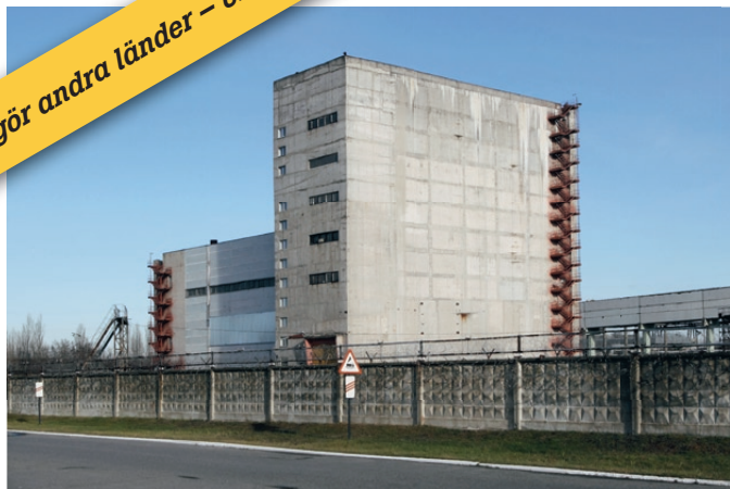
Häriifrån. Något år efter Tjernobylolyckan byggdes den här anläggningen för lagring av radioaktivt avfall. Nu ska en del av det radioaktiva avfallet ...
