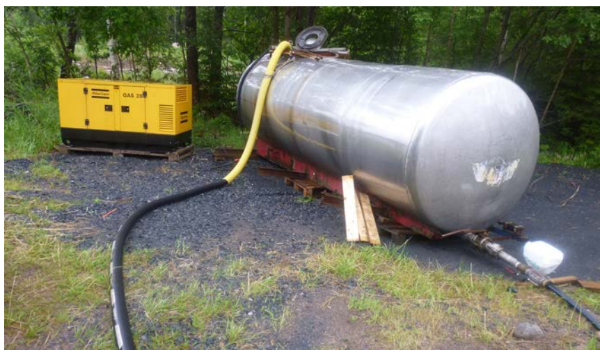
Figur 2-8. Bild på den ståltank som var uppställd i området för tillfälligt boende, i början av vägen till SKB:s undersökningsområde. Till höger i bild syns den tillloppsledning som var inkopplad på FKA:s ledningsnät. Utgående vatten leddes i PEM-slangen från tankens manhål och vidare ut mot tillförselplatsen. Till vänster i bild syns den elgenerator som försedde regleringsventilen, nivåvipporna och den dränkbara pumpen i tanken med el under försöket.
