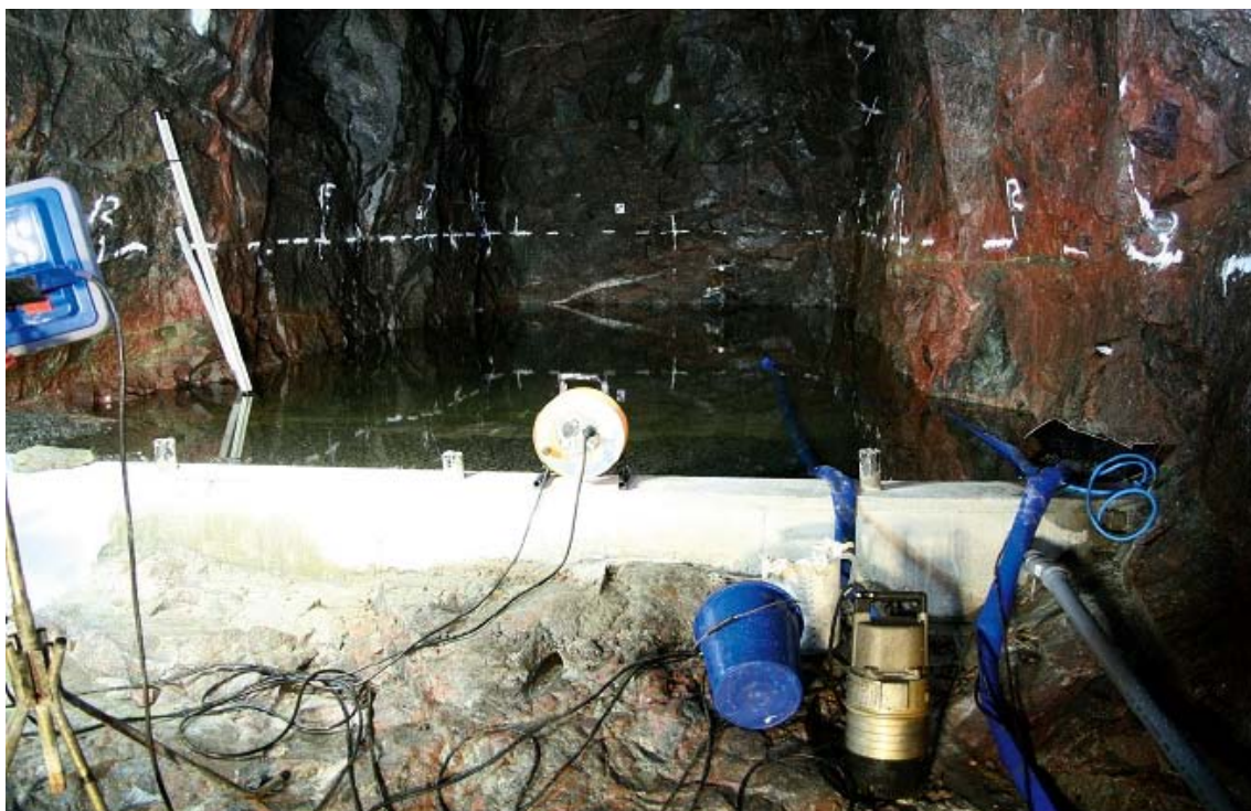
Figur 3-7. Funktionskontroll av mätvall nr 1. Vatten är fyllt innanför mätvallen och nedströms mätvallen är berget rensat. Underkant av mätvallen besiktigas okulärt med avseende på eventuellt vattenläckage mellan betongkonstruktion och berg. Bild: Magnus Kronberg, SKB.
