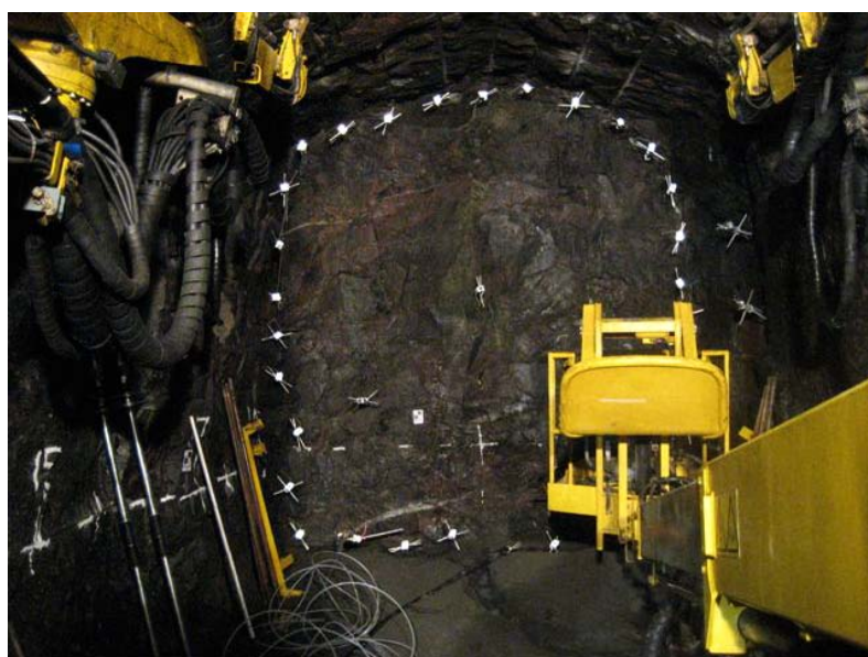
Figur 2-2. TASS-tunneln med borrade och manschetterad injekterings-skärm.
