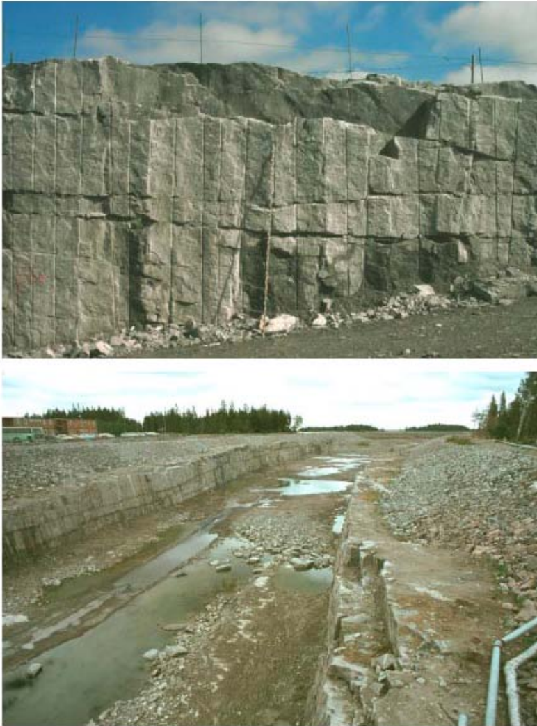
Figur 2-3. Observerade horisontella och subhorisontella sprickor längs kylvattenkanalen /Carlsson och Christiansson 2007/.
