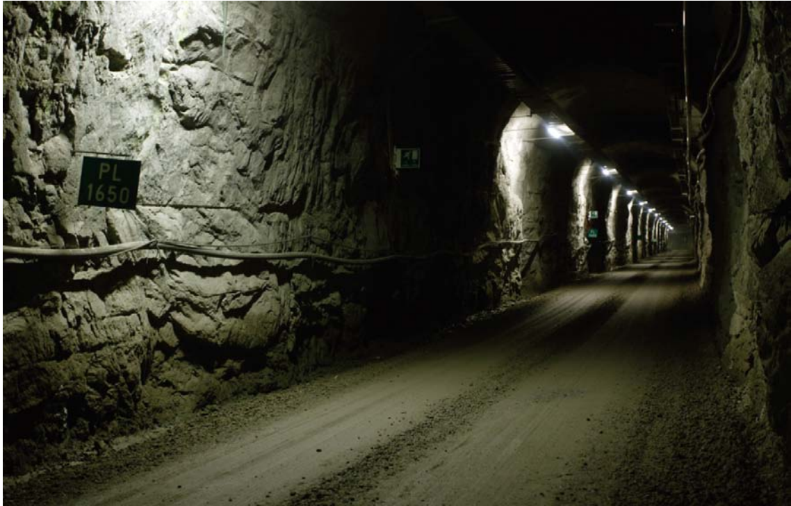
Figur 4-2. Tunnelbygge i Olkiluoto i Finland.
