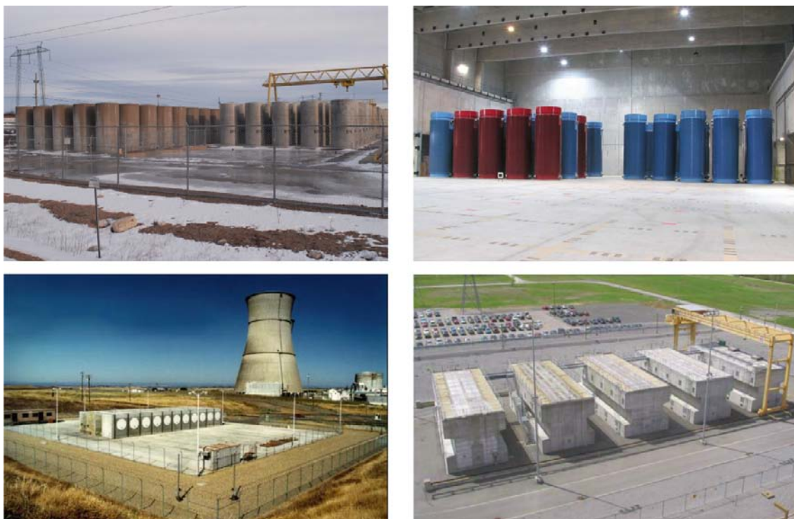
Figur 3-8. Exempel på anläggningar för torr lagring. Överst till vänster: Utomhuslagring vid Point Lepreau Generating Station, källa: NBPower Nuclear. Överst till höger CASTOR®-behållare i lagerbyggnad vid Gorleben i Tyskland /från Vossnacke et al. 2003, källa: IAEA/. Nederst till vänster NUHOMS® vid Susquehanna kärnkraftverk i USA /från Roland et al. 2003, källa: IAEA/. Nederst till höger CANSTOR®-moduler vid Gentilly-2 i Kanada /från NWMO 2004, källa: Hydro Quebec/.
