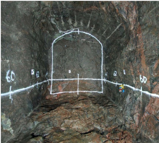
The Tass-tunnel in Äspö HRL.
