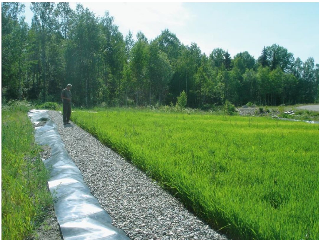
Figur 4-5. Översilningsanläggning för lakvatten på Kvittens avfallsanläggning, Strängnäs kommun. (Foto: D Stråe, WRS Uppsala AB).
