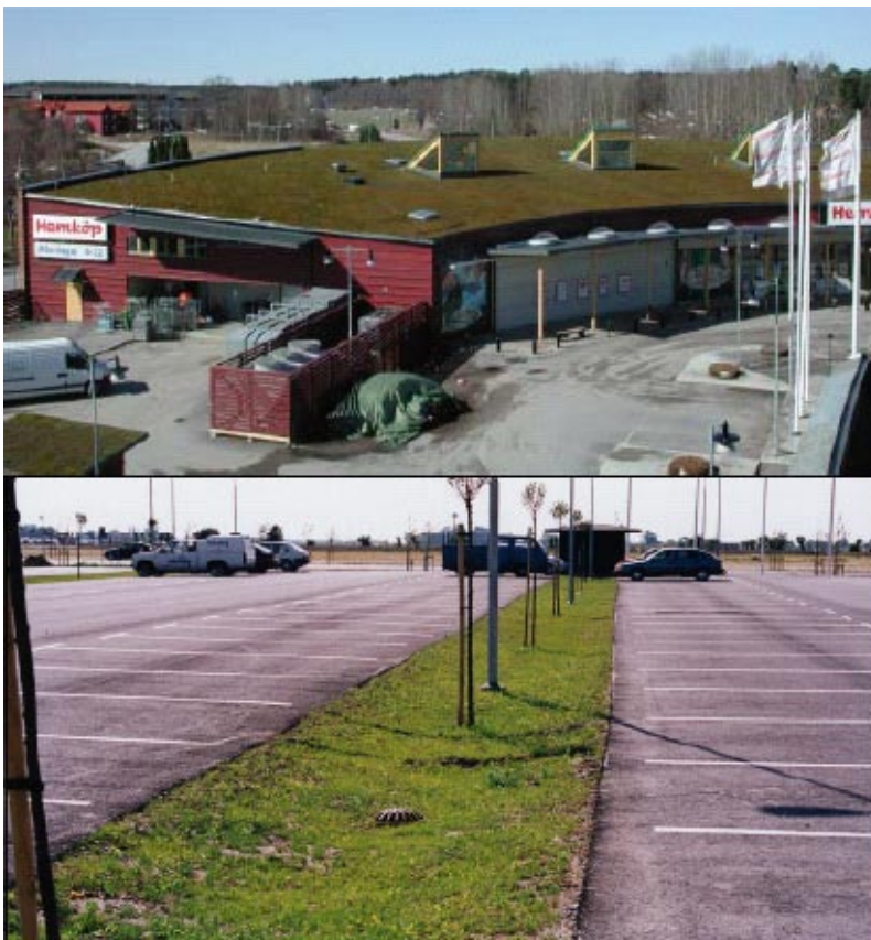
Figur 4-7. "Grönt tak", parkering med skåldike för infiltration i underliggande porvolym samt öppna, flacka diken för utjämning, filtrering, sedimentation och biologisk nedbrytning. (Foto: A Jacobs, Täby k:n (överst), U Thysell, VASYD (nederst).
