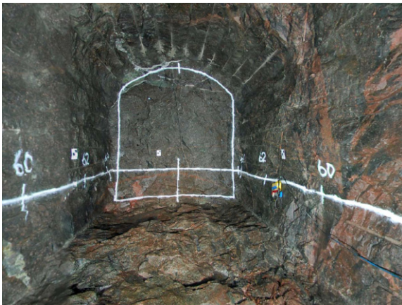
Tass-tunnel in Äspö HRL
