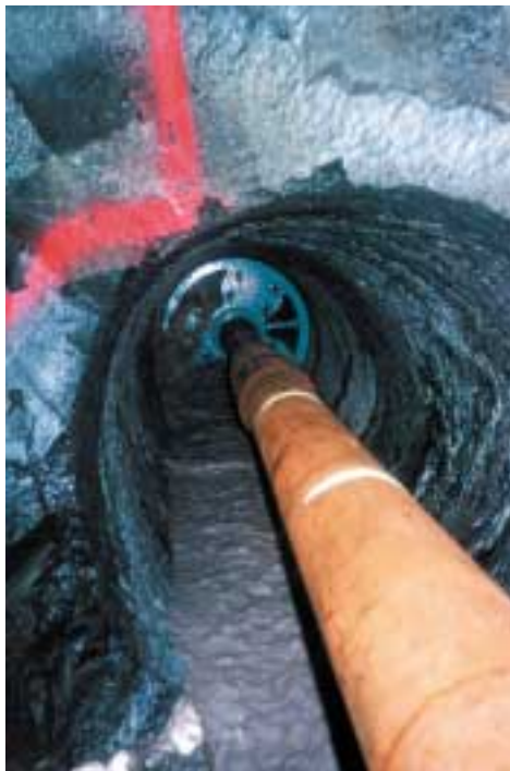
Figur 8-3. Borrning med cluster.
