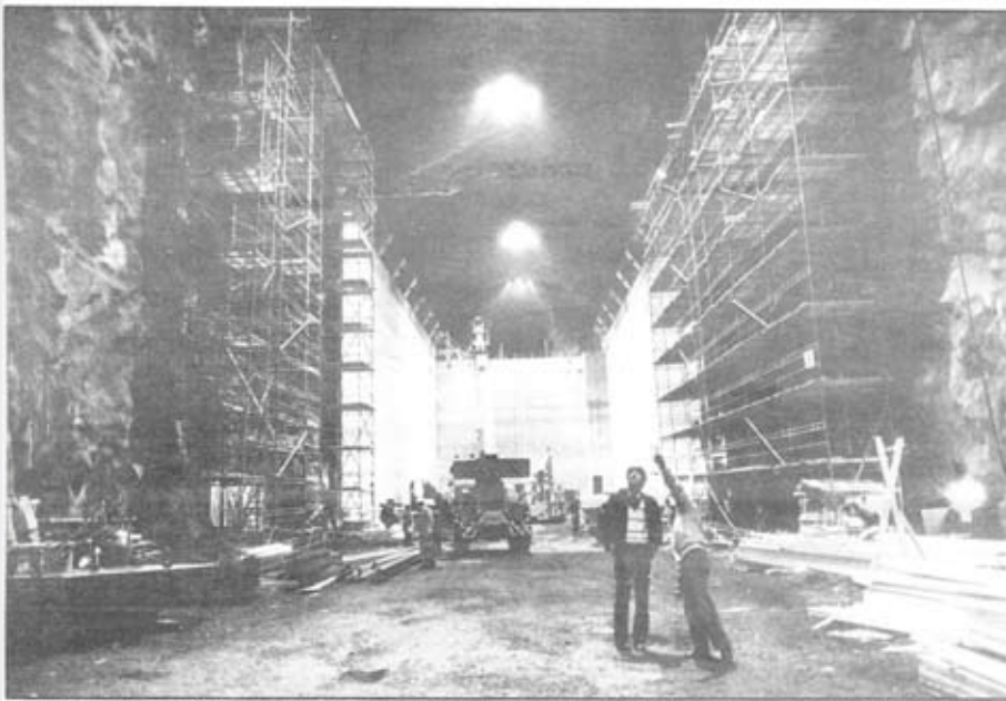
Den största bergskalle ligger drygt 80 meter ner i det omåttliga berget. 120 meter lång och 21 meter bred - rymmer tre reaktorreaktor i rad - och det är 27 meter upp till taksvart. Foto: JAY HOLMELAND
