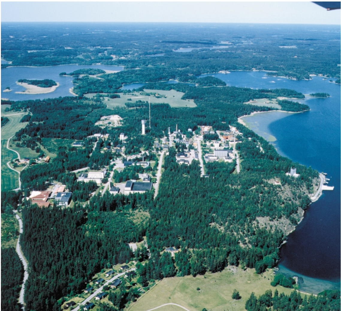
Figur 3-4. Studsviksanläggningen med omgivning.
