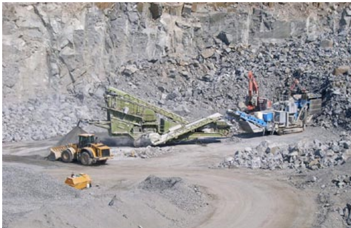
Figur 4-2. Mobil krossanläggning för krossning av t ex tunnelberg.
