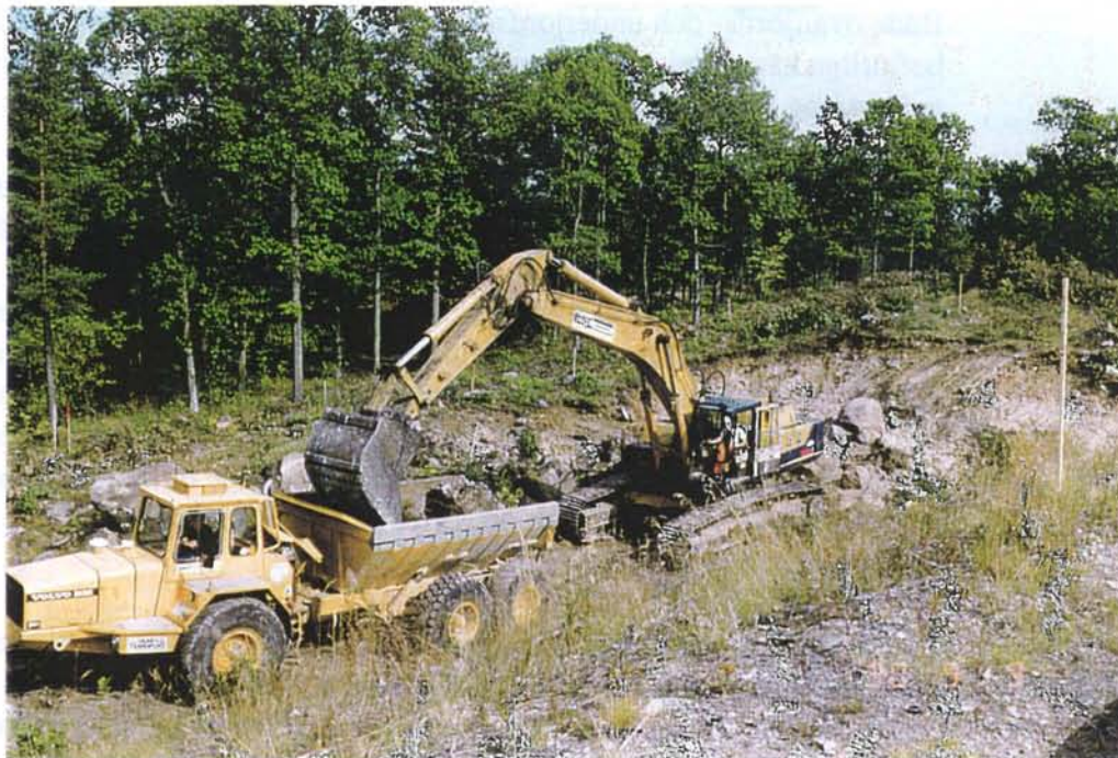
Figur 4-2. Anläggande av tunnelpåslag till Äspölaboratoriet.
