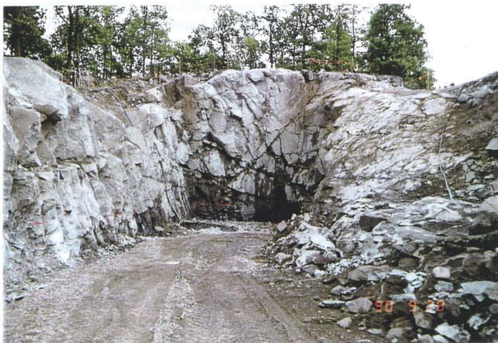
Figur 4-4. Tunnelpåslaget till Äspölaboratoriet.
